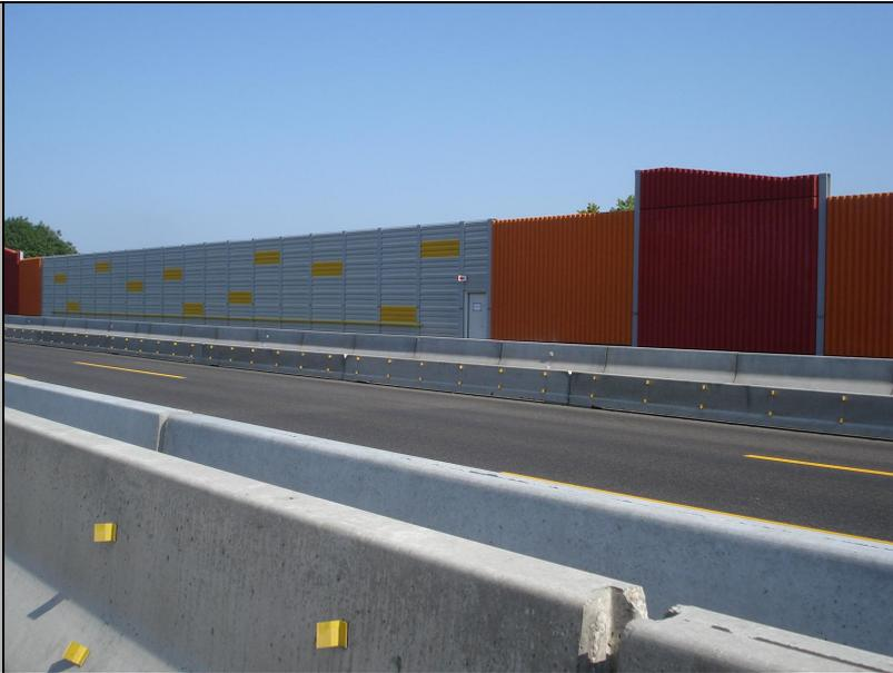
Das Regierungspräsidium Stuttgart, Außenstelle Heilbronn, baut die 4-spurige BAB A6 zwischen AS Sinsheim-Steinfurt und AS Bad Rappenau grundhaft auf sechs Fahrspuren plus Standstreifen aus. Im Zuge dieser Maßnahme werden Lärmschutzwände entlang der A6 gebaut, wofür die Implenia Spezialtiefbau GmbH den Auftrag erhielt.
