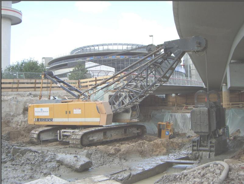
Die Arbeitsgemeinschaft Spezialtiefbau Flughafen S-Bahn unter Beteiligung der Implenia Spezialtiefbau stellte für die neue S-Bahn-Anbindung des Flughafens Hamburg die Trogbaugrube sowie die Start- und Zielbaugruben für den Tunnelvortrieb, einschließlich eines Dichtblocks am Startschacht, her.
