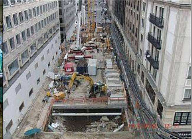
Nachdem beide Tunnelröhren aufgefahren sind, wird der Baugrund um die beiden Tunnelröhren im 105 m langen Teilstück zwischen der östlichen und der westlichen Baugrube vereist. Der Einbau der Vereisungsrohre erfolgt von der östlichen Baugrube aus in steuerbare Bohrungen von ca. 15 cm Durchmesser. Im Schutze des Eisgewölbes werden dann die beiden Tunnelröhren bergmännisch aufgebrochen und auf die Abmessungen der geplanten Bahnsteiganlage aufgeweitet.
